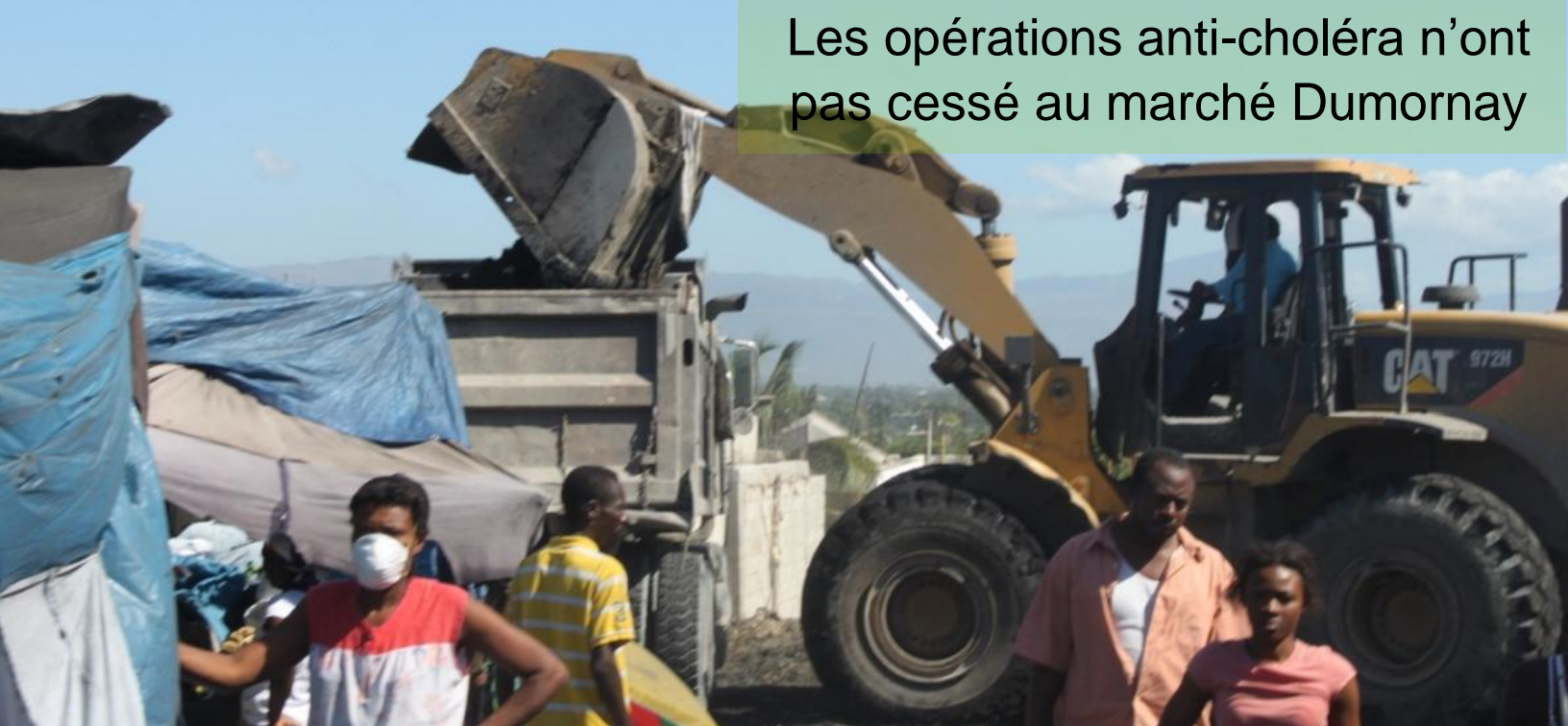
Opérations de destruction du dépotoir sauvage au marché Dumornay
