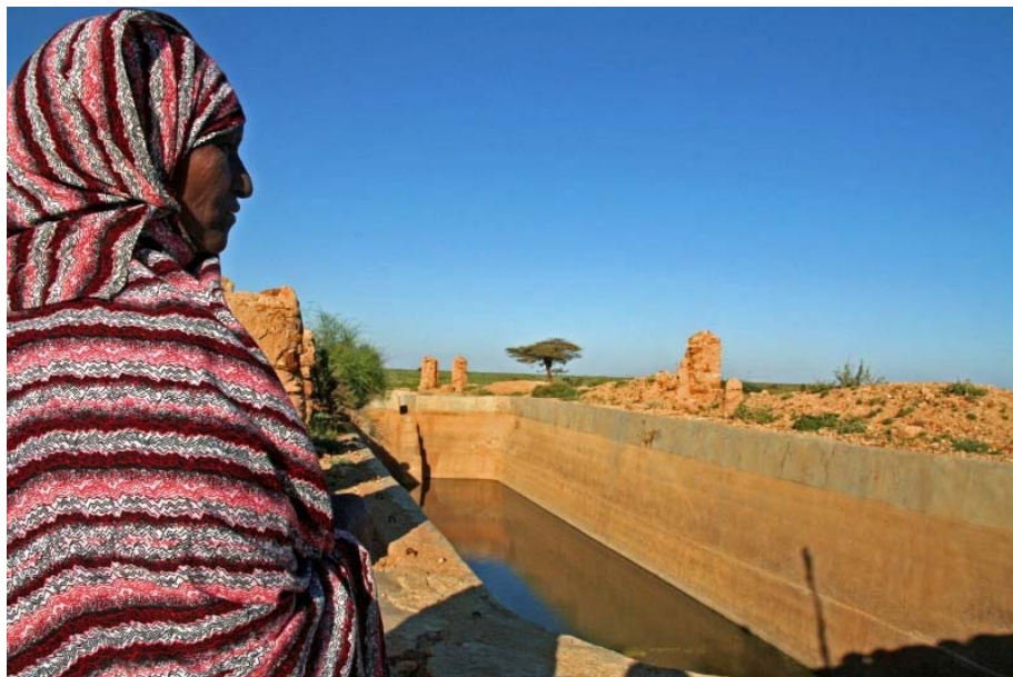
Saraha Malmud Muhumed à côté d'un birkhad construit par Oxfam, un bassin protégé collectant les eaux de pluie et utilisé lors de la longue saison sèche, Harshin, région Somali. Photo : Oxfam/Maite Alvarez
