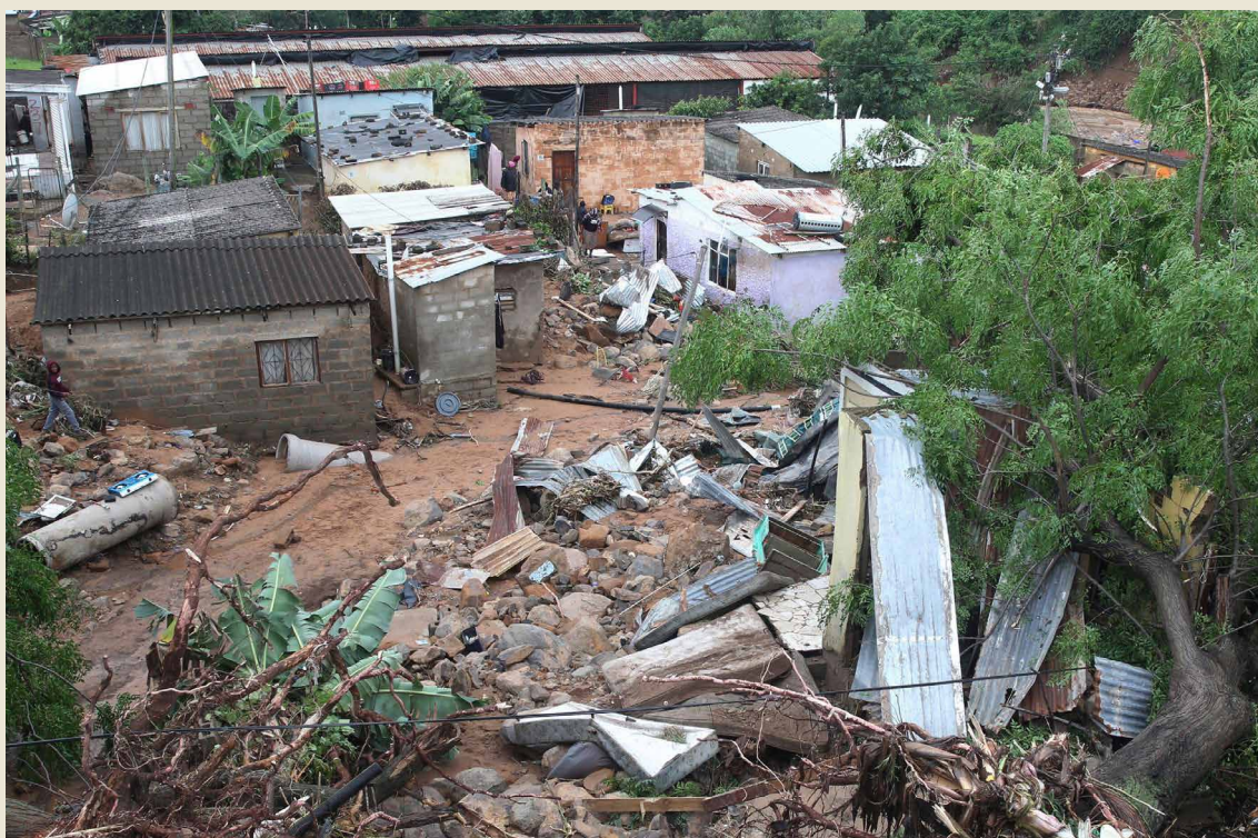
Des logements ont été emportés, à Ntuzuma, aux abords de Durban, en Afrique du Sud, le mardi 12 avril 2022. Des pluies prolongées et des inondations ont fait de nombreuses victimes dans la province sud-africaine de KwaZulu-Natal. Photo : AP Photo/Str/Alamy
